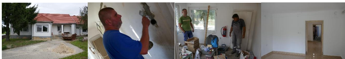
A Bogád, Kossuth utca 42. számú önkormányzati tulajdonú ingatlan belső felújítása
